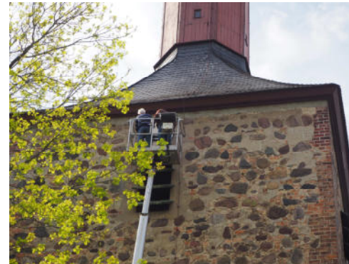
Ausbau des Zifferblatts
